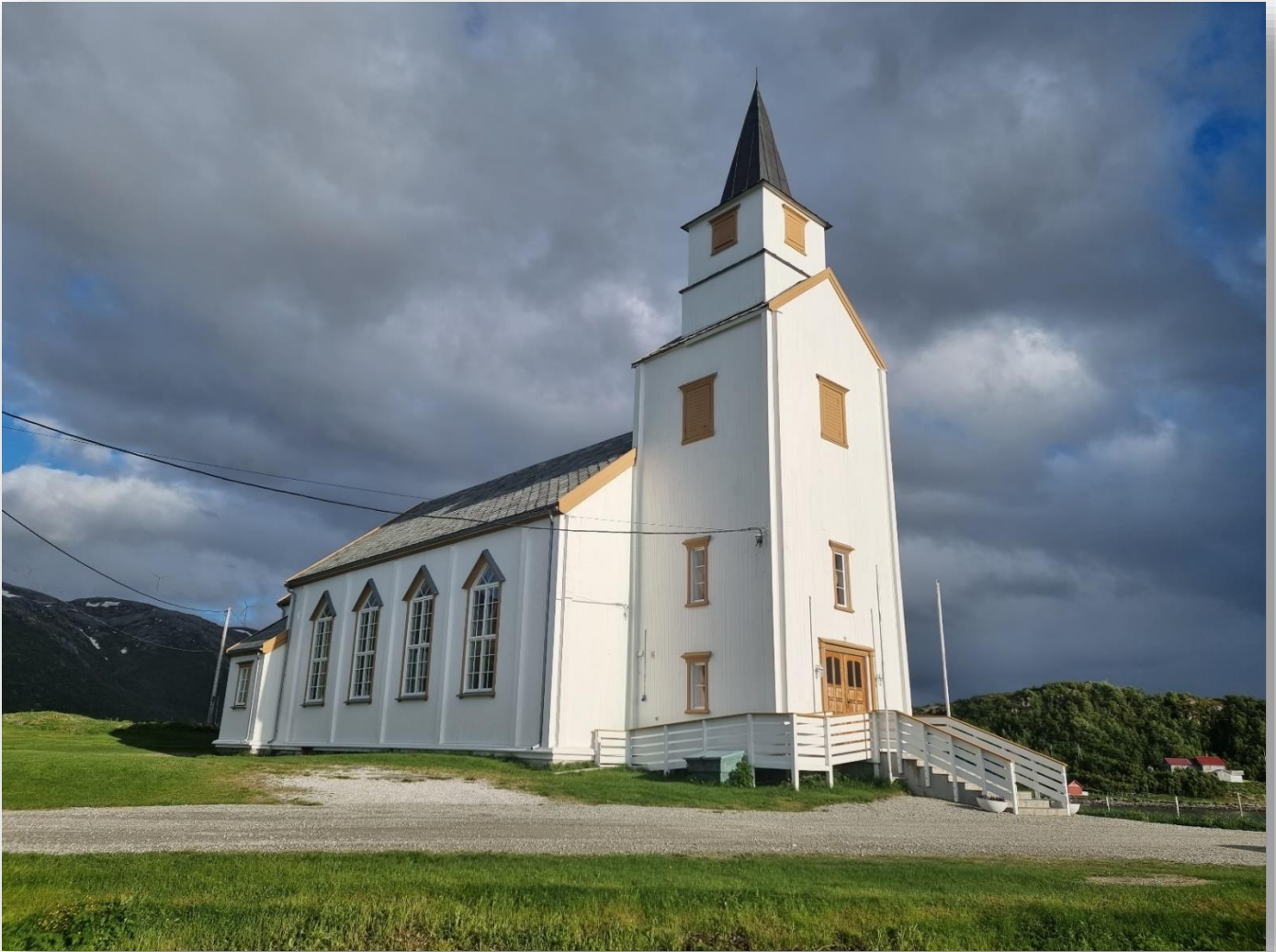
Hillesøy kirke – prosjekteres for ny og mer energieffektiv løsning med varmepumper
