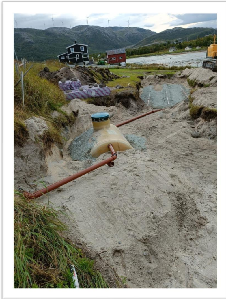
Bildet viser byggingen av nytt godkjent avløpsanlegg ved Hillesøy kirke – Foto: Leif Guttormsen
