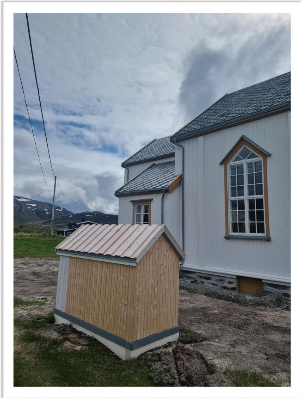
Bildet er fra Hillesøy kirke og de nye varmpumpehusene til Kirka som ble ferdigstilt i 2023 – Foto: Leif Guttormsen
